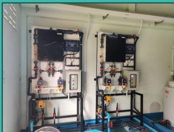
ระบบผลิตคลอรีนไดออกไซด์ ( \text{ClO}_2 )
