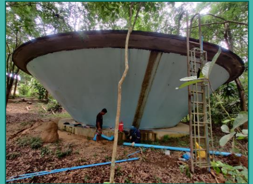
หอเก็บน้ำ คสล. เขาโป่งลาน ความจุประมาณ 150 ลบ.ม.
