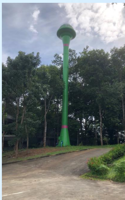
ระบบสูบน้ำขึ้นหอถังสูงสำหรับระบบท่อน้ำดิบรดน้ำต้นไม้/สนามหญ้า
