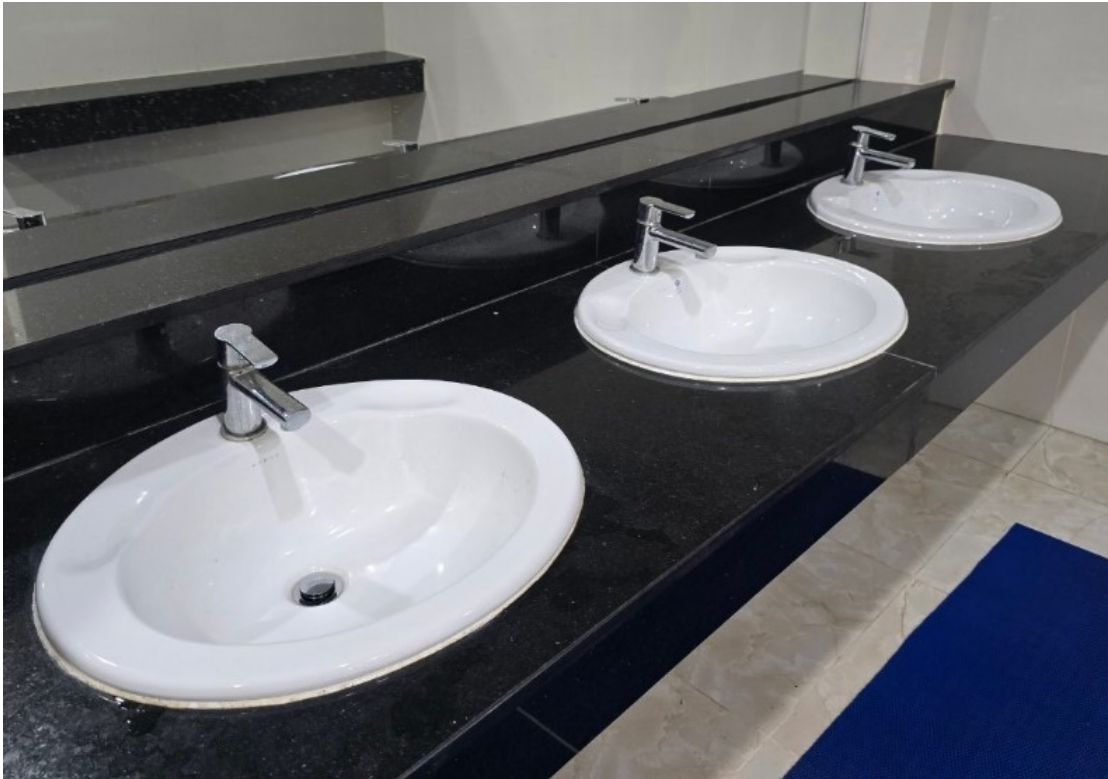
1.3 ก๊อกน้ำที่มีปริมาตรการใช้น้ำไม่เกิน 6 ลิตร/นาที
