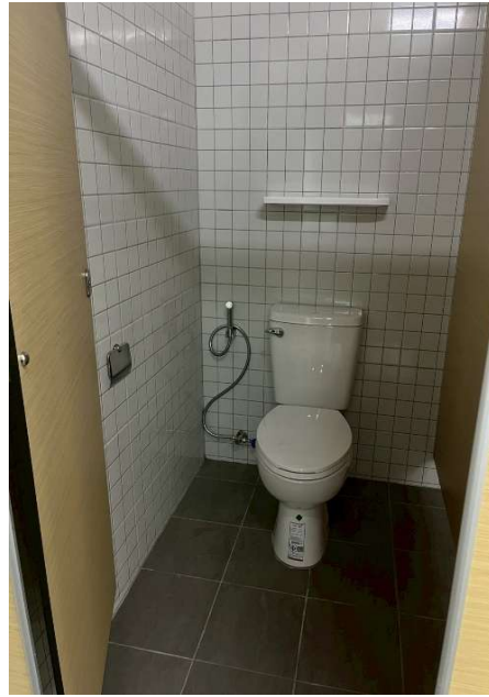
1.1 ห้องน้ำ เลือกใช้โถสุขภัณฑ์ที่ใช้น้ำในการชำระล้างต่อครั้ง ไม่เกิน 6 ลิตร
