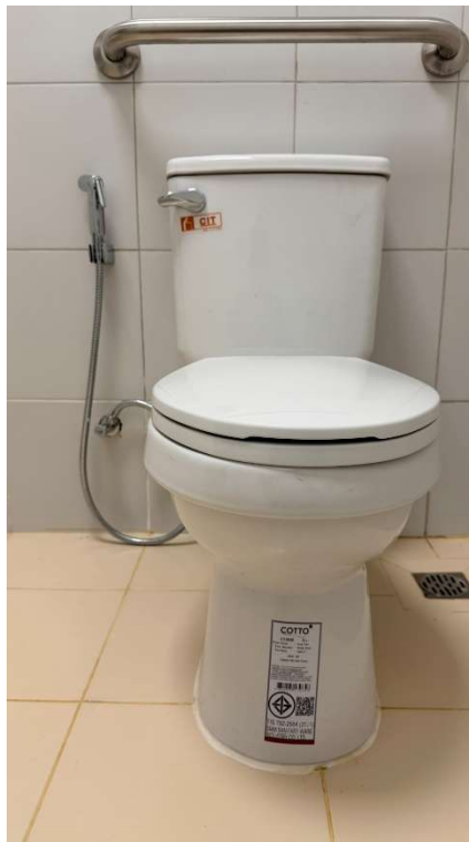
1.2 ห้องน้ำ เลือกใช้โถสุขภัณฑ์ที่ใช้น้ำในการชำระล้างต่อครั้ง ไม่เกิน 6 ลิตร
