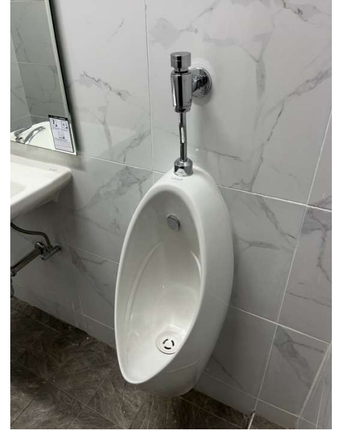
1.2 โถปัสสาวะ ระบบฟลักซ์เลือกที่มีปริมาตรการใช้น้ำไม่เกิน 6 ลิตร
