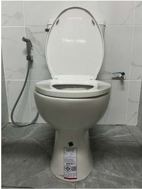
1.1 ห้องน้ำ เลือกใช้โถสุขภัณฑ์ที่ใช้น้ำในการชำระล้างต่อครั้ง ไม่เกิน 6 ลิตร
