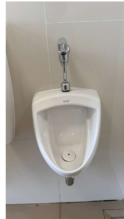
1.3 โถปัสสาวะ ระบบฟลักซ์เลือกที่มีปริมาตรการใช้ไม่เกิน 6 ลิตร/ โดยเลือกใช้น้ำในการชำระล้าง 3 ลิตรต่อครั้ง
