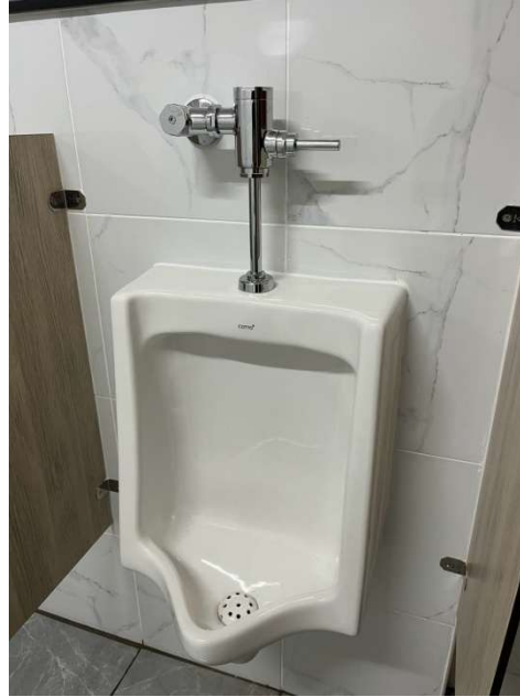
1.2 โถปัสสาวะ ระบบฟลักซ์เลือกที่มีปริมาตรการใช้น้ำไม่เกิน 6 ลิตร
