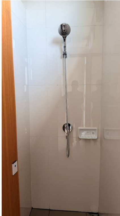
1.6 ฝักบัวปริมาณการใช้น้ำไม่เกิน 6 ลิตร/นาที
